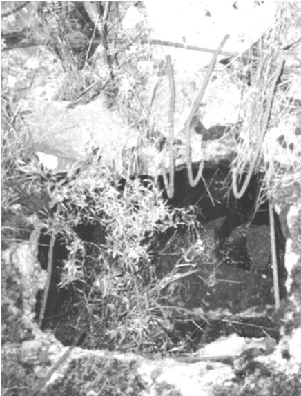
Abb. 36a: Angebliches Zyklon-B-Einwurfloch in der Decke des Leichenkellers I („Gaskammer“) von Krematorium II
