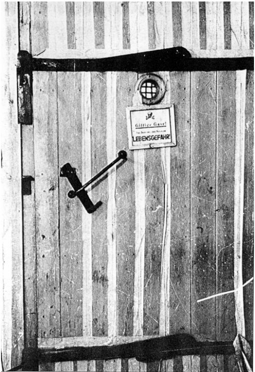
Abb. 38: „Gasdichte“ Holztür einer Entwesungskammer in Auschwitz mit Guckloch. (So sollen auch die gasdichten Türen für die Menschen-„Gaskammern“ ausgesehen haben.)
